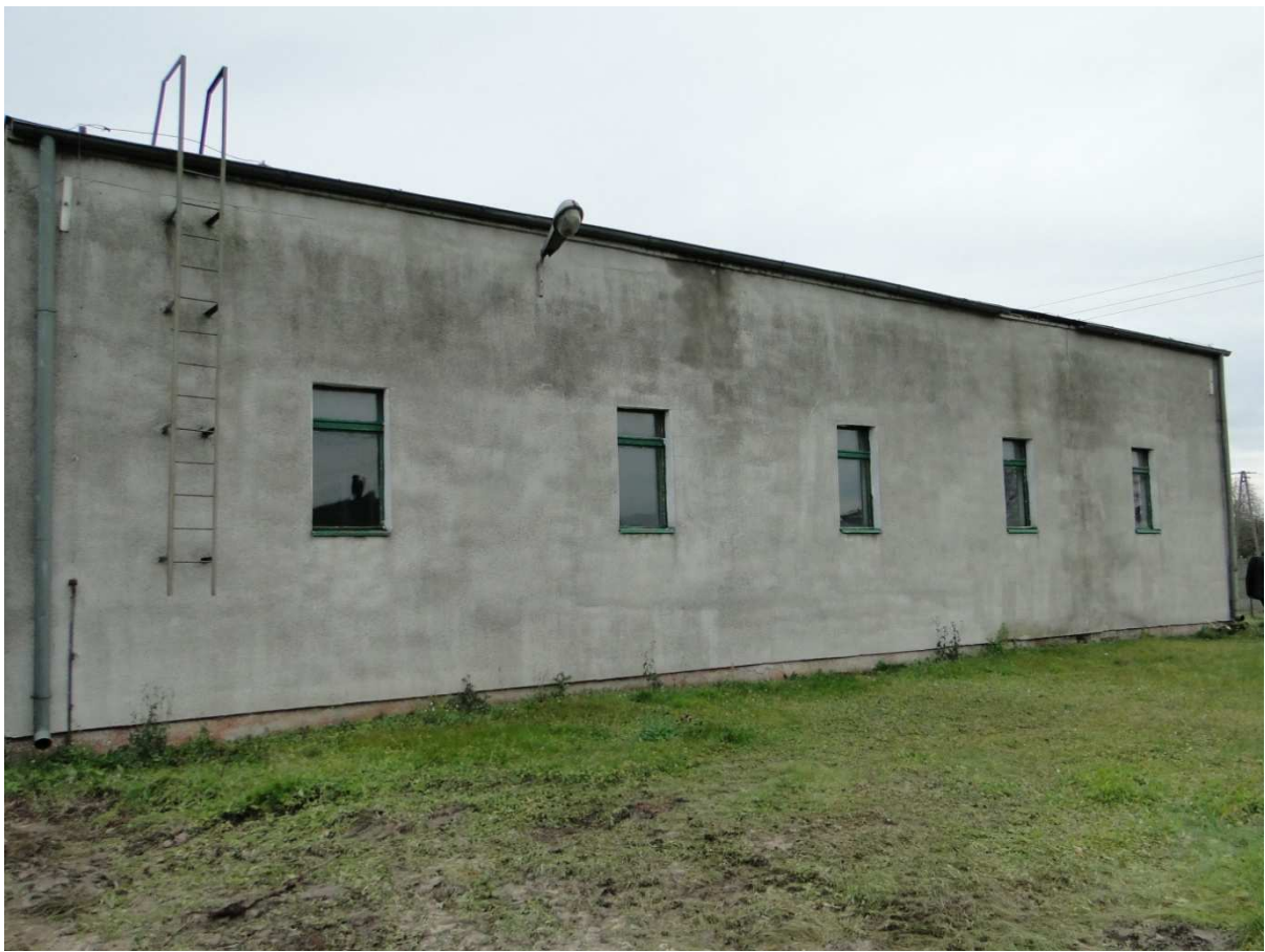
Fot. 3 – Widok elewacji od strony zachodniej
