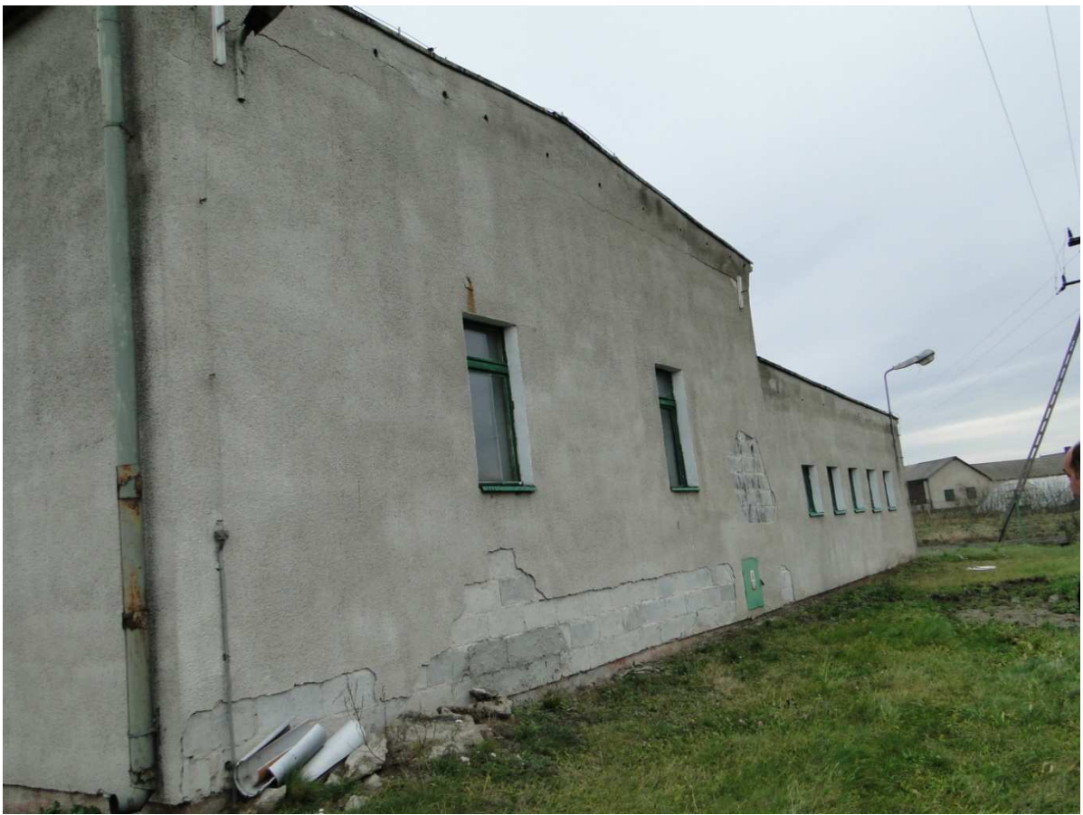
Fot. 5 – Widok elewacji od strony południowej
