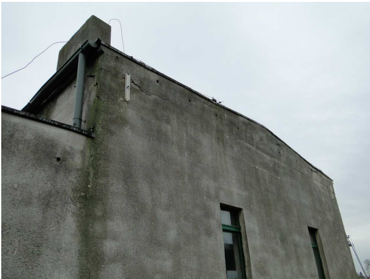
Fot. 1 – Widok elewacji od strony północnej
