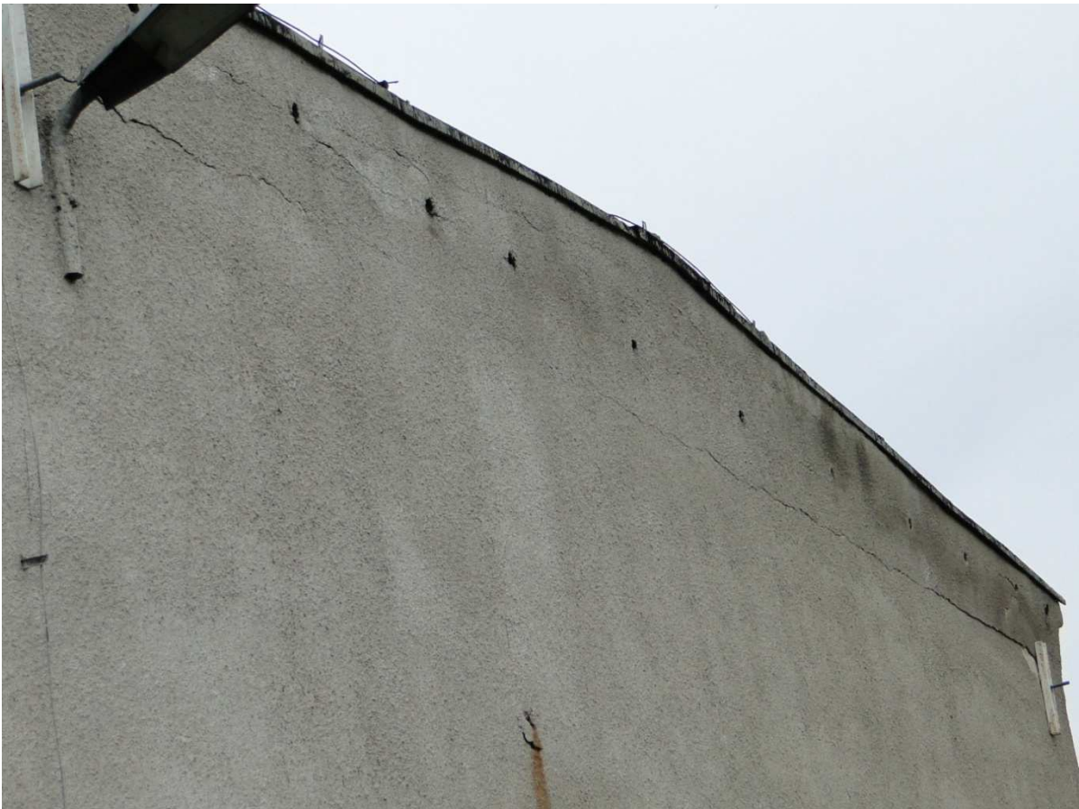
Fot. 6 – Widok elewacji od strony południowej
