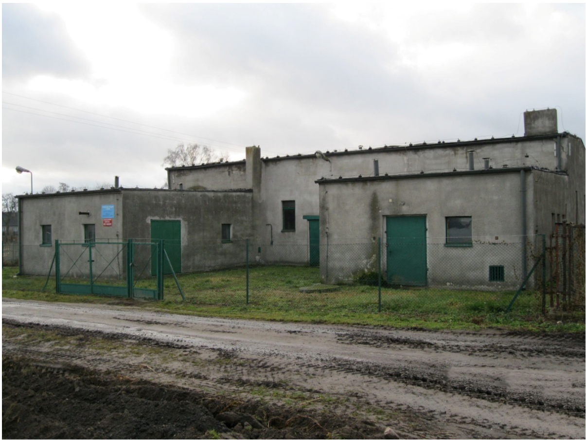
Fot. 7 – Widok elewacji od strony wschodniej
