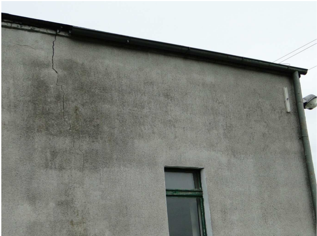
Fot. 4 – Widok elewacji od strony zachodniej
